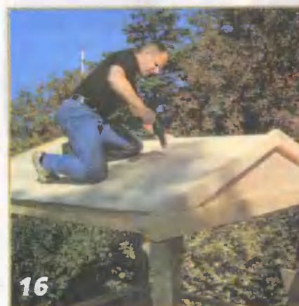
Поднимают обе панели крыши и 40-мм шурупами прикрепляют их к фермам крыши и верхней перемычке Е.
