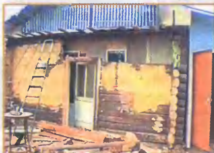
За стеной разобранного сруба видна временная стена. Фронтон закрыт полиэтиленовой пленкой.
