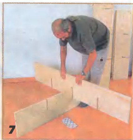
7 Раскроенные детали тщательно шлифуют, особенно обращая внимание на острые кромки и углы.
