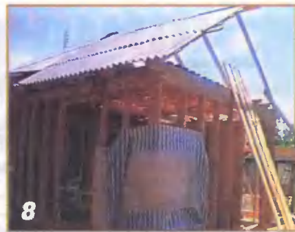
Каркас нового дома и половина крыши.
