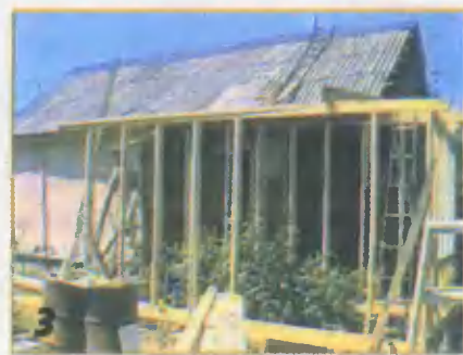
3 Установка каркаса веранды.
