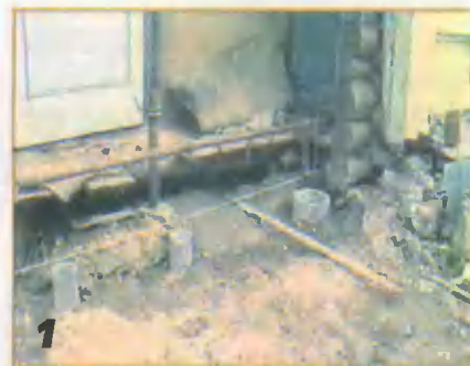
1 Подпорка поддерживает крышу. На снимке видны также асбоцементные трубы фундамента.
