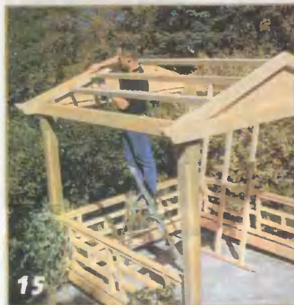
Поднимают фермы крыши и 70-мм шурупами прикрепляют их заподлицо с панелями фронтонов.
