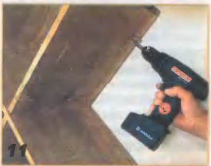
11 Для крепления этажерки к стене применяют дюбели и стальные держатели с отверстиями.
