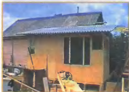
Кровля уложена, а веранда обшита фанерой.
