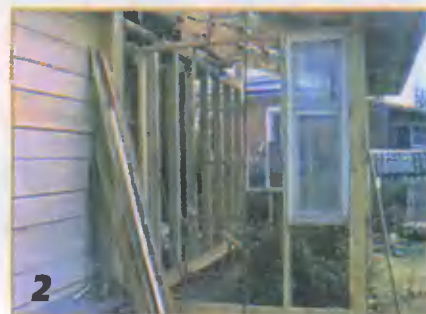
2 Фрагмент каркаса стены пристройки.
