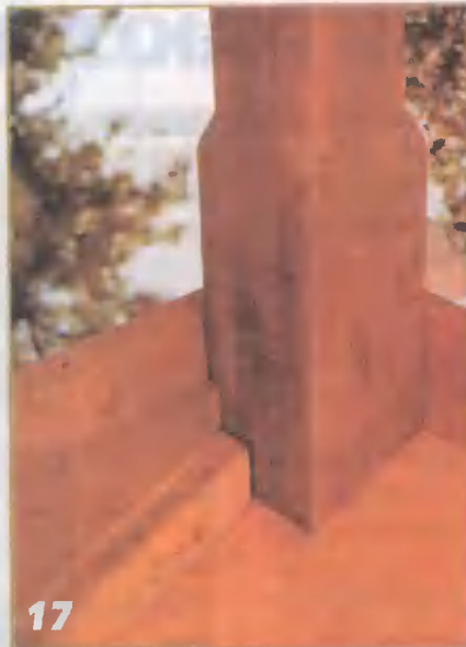
С внутренней стороны видно, как доски фронтона Р устанавливают между стоек.
