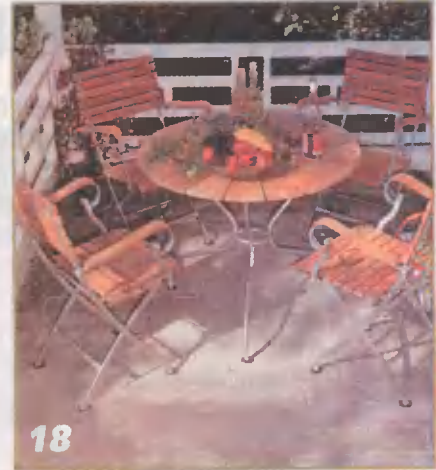
Терраса застелена серыми бетонными плитками. Швы заполнены мелким речным песком.
