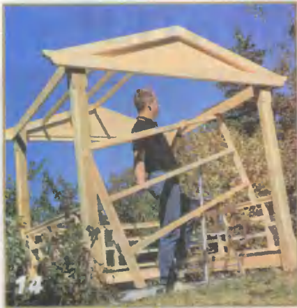
Из деталей К и L на 80-мм шурупах собирают фермы крыши.
